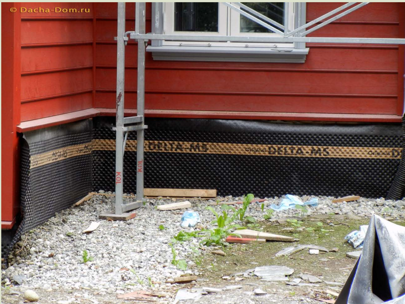
Фотография №5. Дренажная гофрированная гидроизоляция Delta
